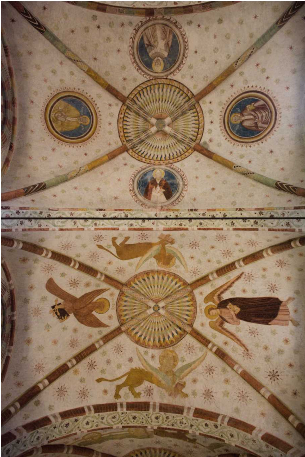
fig. 176. Lodi Vecchio, San Bassiano, voûtes deux travées centrales de la nef
