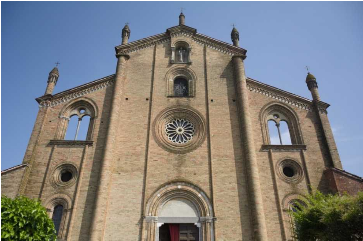
fig. 172. Lodi Vecchio, San Bassiano, façade de l'édifice
