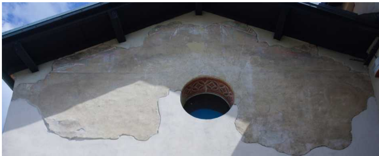
fig. 20. Albizzate, Oratoire « visconteo », façade (détail)
