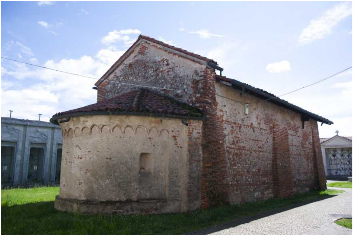
fig. 3. Caltignaga, San Salvatore, vue extérieure, angle nord-est
