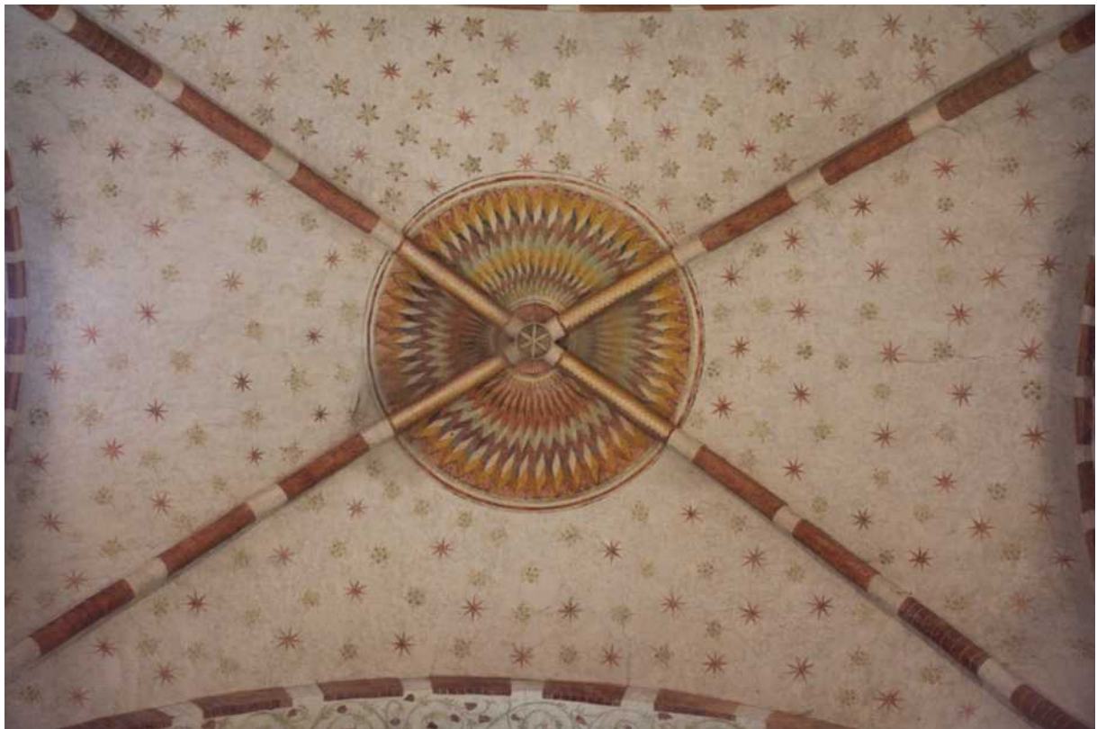
fig. 175. Lodi Vecchio, San Bassiano, voûte de la première travée de la nef (en partant de l'entrée)
