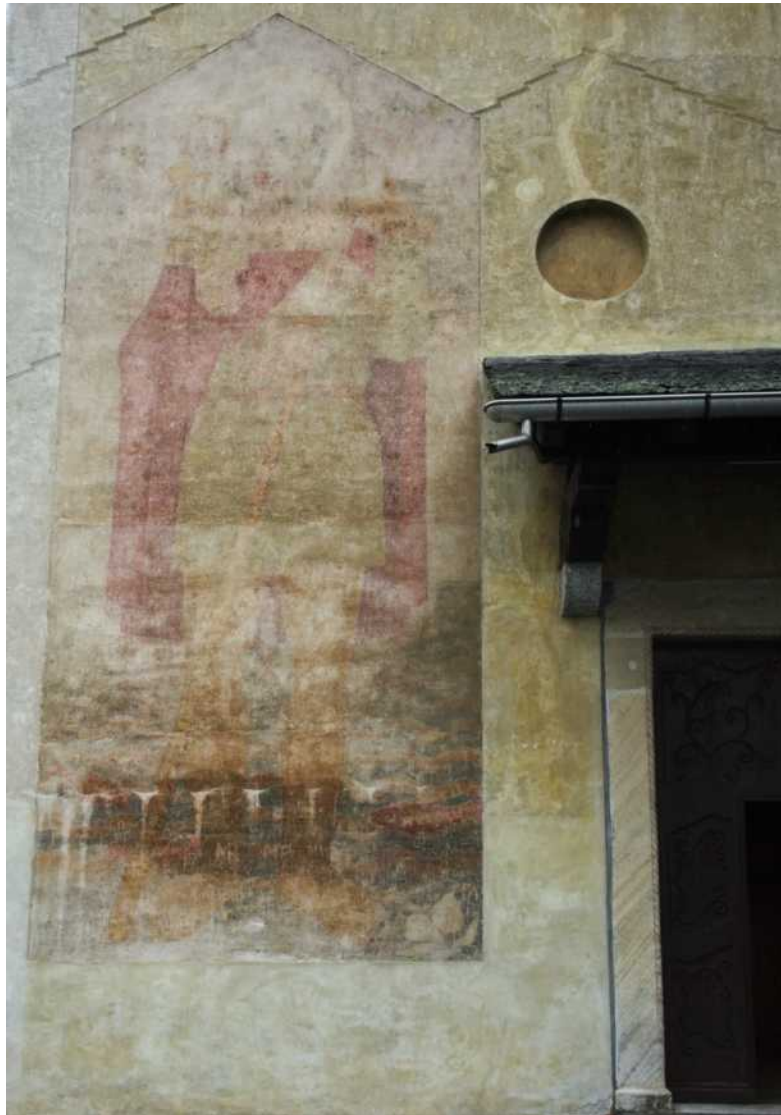
fig. 147. Giubiasco, Santa Maria Assunta, saint Christophe, façade principale
