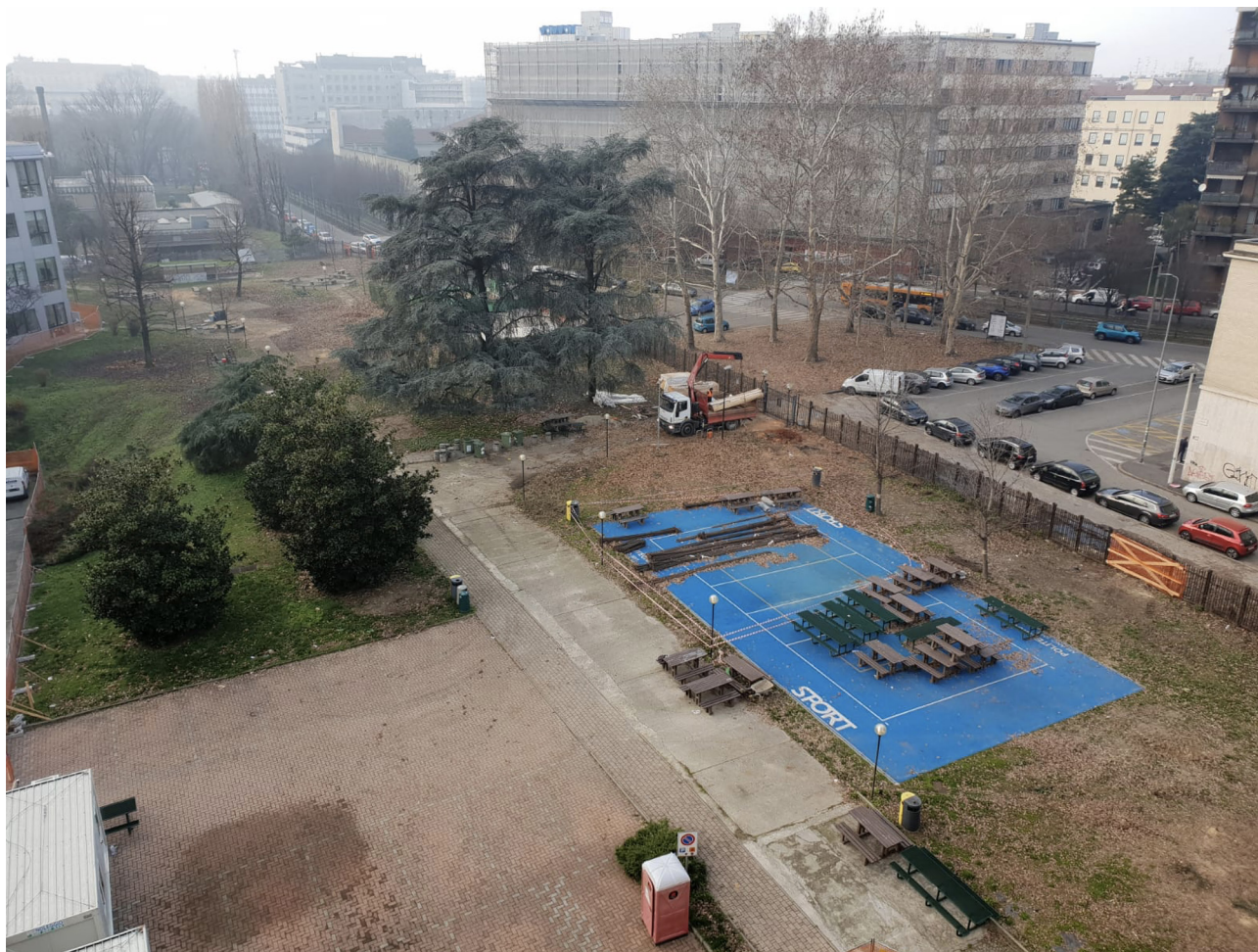
Figura 3. Veduta aerea dell'area durante i lavori di smantellamento. Fonte: Foti, 2020.
