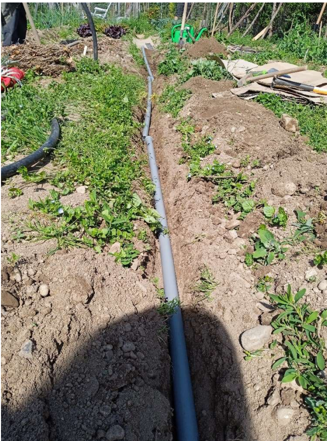
Figura 26. Lavori di costruzione del sistema di irrigazione, aprile 2023. Fonte: CAPOCEFALO 2023.
