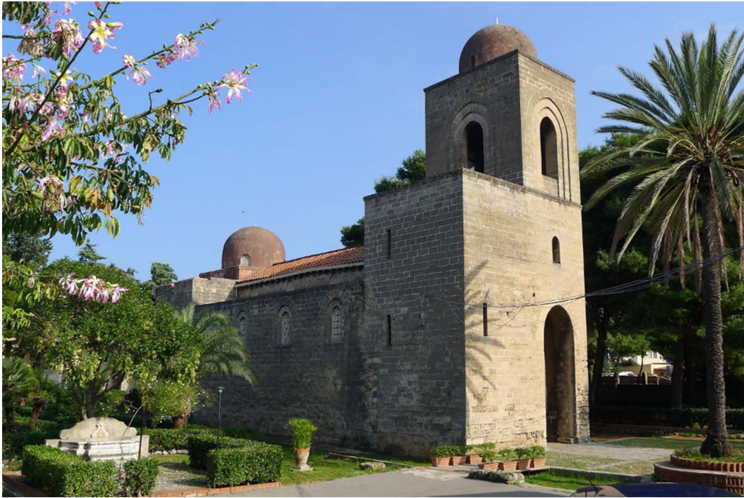
Figure 4 – General view of San Giovanni dei Lebbrosi
