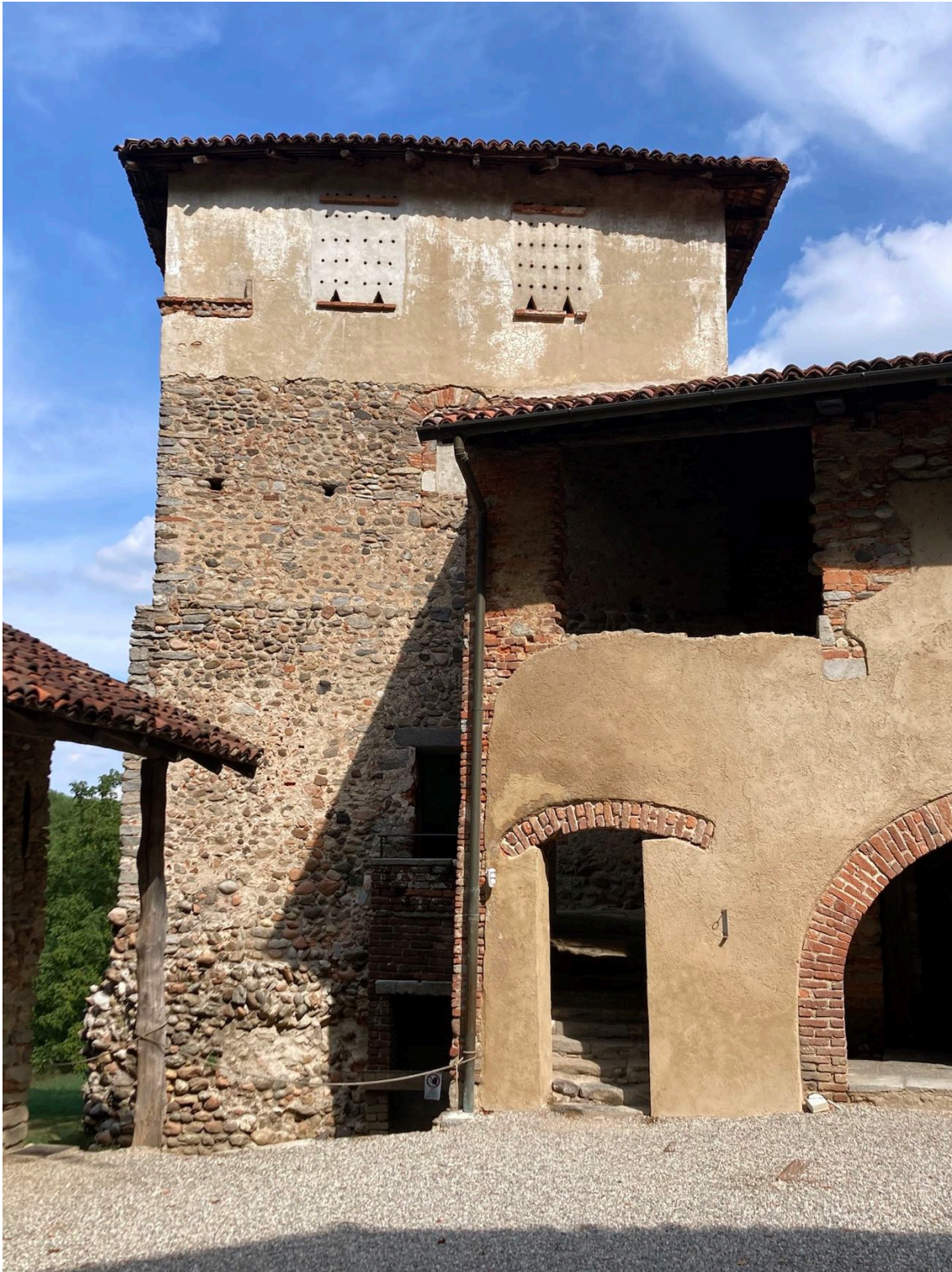
4 Torba, torre tardoantica, prospetto occidentale, in parte coperto dal portico bassomedievale. Dal basso: accesso seminterrato al primo livello, accesso balconato al secondo livello, finestra murata del terzo livello, sopraelevazione di XV secolo (foto di Guido Dibiase, 2022)
