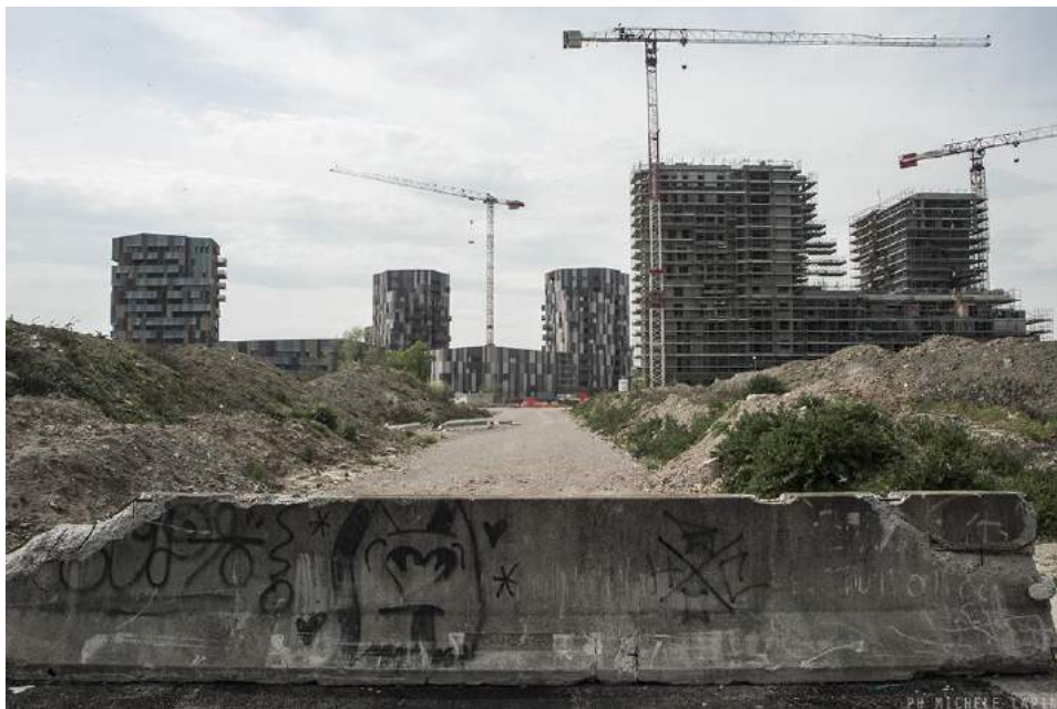
Fig. 8. Il cantiere di piazza Liber Paradisus.
