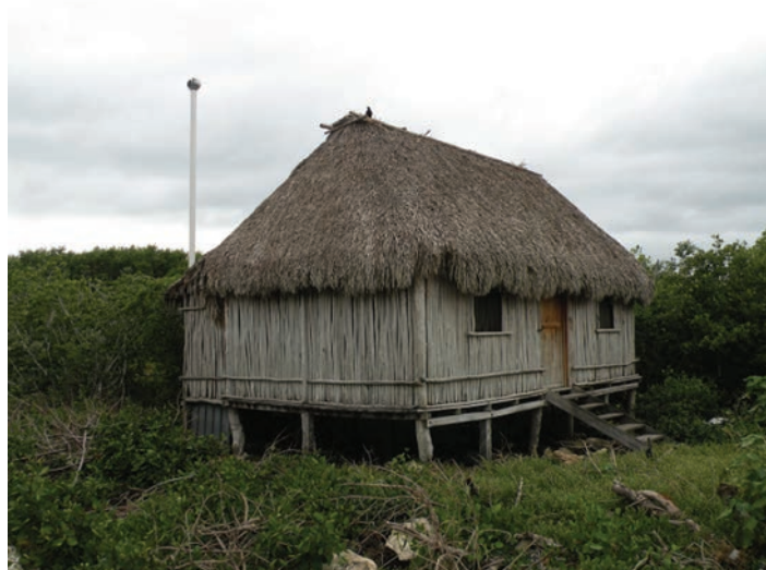
Foto 7. Casa sobre pilotes en San Felipe, 2014 (Foto: J.A.).
