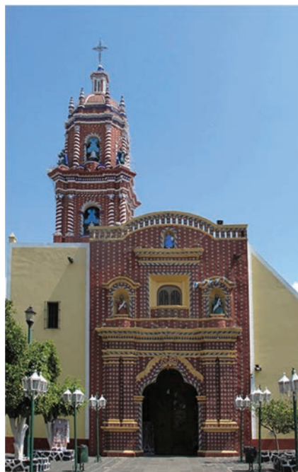
Iglesia de Santa María Tonantzintla (Puebla). Vista de la fachada. Foto de M. a Celia Fontana.
