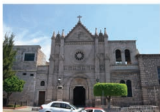
Figura 2. Fachada del Templo María Auxiliadora. Foto 2015.
