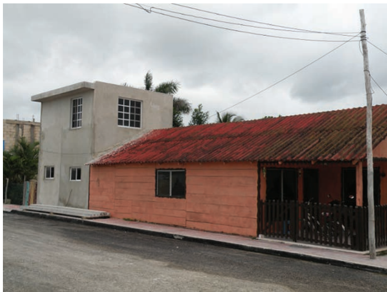
Foto 5. Ampliación de la casa tradicional por el programa de Mejoramiento de vivienda, San Felipe 2014.
