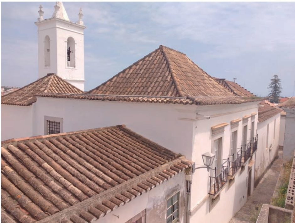
Fig. 4. Casa da Misericórdia de Tavira (fachada lateral) (Joana Balsa de Pinho).
