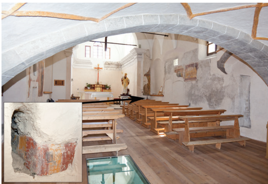
Fig. 26. Valdidentro, località Premadio, San Gallo. Interno visto dall'ingresso, sotto la tribuna. La parete destra ingloba parte del primitivo perimetrale romanico. In corrispondenza dell'innesto del presbiterio seicentesco è tornato in luce l'attacco dell'emiciclo absidale romanico, ornato da cornice a bande giuntate da filo di perle e gemme, evidenziata nel riquadro (foto dell'Autore).
