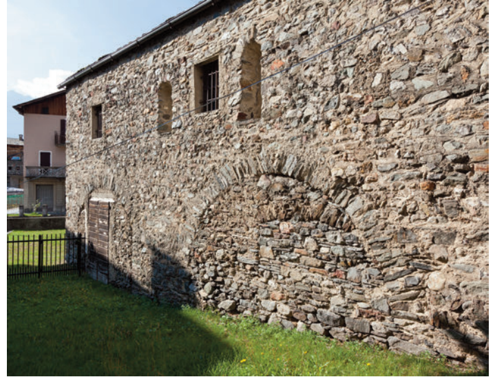
Fig. 7. Teglio, San Pietro. Fianco nord, con le due arcate aperte in rottura in età bassomedievale e tamponate ab antiquo (foto dell'Autore).
