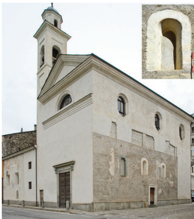
Fig. 14. Mazzo di Valtellina, Santa Maria. Il perimetrale sud ingloba parte del muro romanico, con monofore strombate (dettaglio di quella centrale); a lato della facciata si allinea un annesso rinascimentale, forse su preesistenze medievali (foto di Alessandro D'Alfonso, rielaborata).
