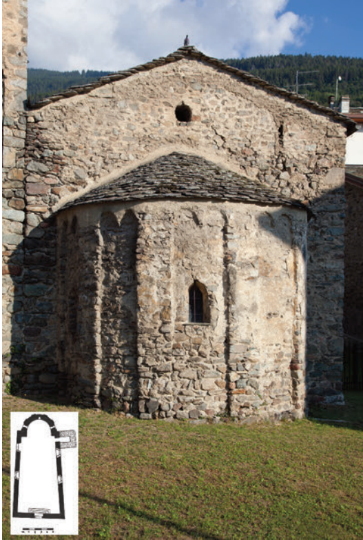
Fig. 6. Teglio, San Pietro. Prospetto absidale, con resti di intonaco di prima fase (?) fra le specchiature binate (foto dell'Autore; planimetria da MAGNI 1960).
