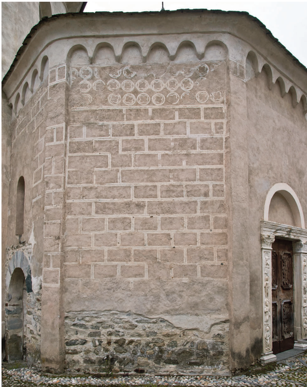
Fig. 10. Mazzo di Valtellina, battistero di San Giovanni. Nella specchiatura sinistra, il portale (tamponato) in conci sagomati e la soprastante monofora ad arco leggermente oltrepassato e schiacciato; nella specchiatura centrale, in basso, il paramento di pietre sbazzate e ciottoli in abbondante malta stilata, visibile grazie alla lacuna dell'intonaco rinascimentale; nella specchiatura destra, già dotata di scarsella, il portale datato 1508, di provenienza ignota e montato nel XIX secolo (foto di Alessandro D'Alfonso, rielaborata).
