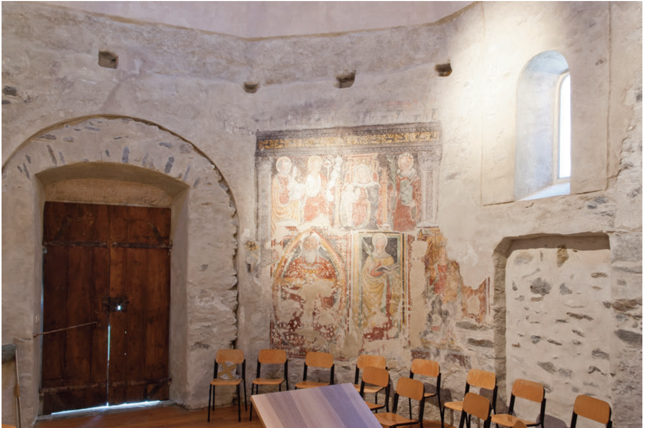
Fig. 12. Mazzo di Valtellina, battistero di San Giovanni. A sinistra, l'arco tamponato che immetteva nella scarsella; al centro, sopra il riquadro rinascimentale, tracce del meandro policromo a T; a destra, il portale tamponato; in alto, in corrispondenza della risega, buche per travetti lignei (foto dell'Autore).
