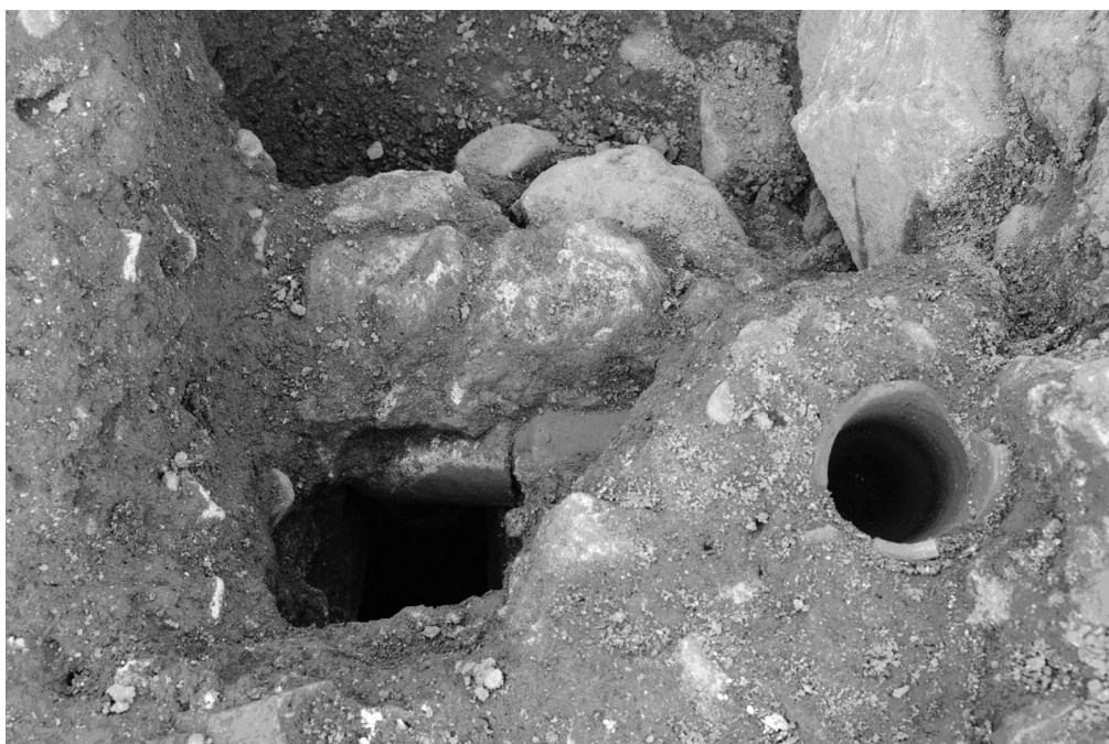
Fig. 5: La canaletta di adduzione centrale in terracotta della cisterna 37; si conservano integri i due segmenti finali ad angolo, l'uno inserito nell'altro.
