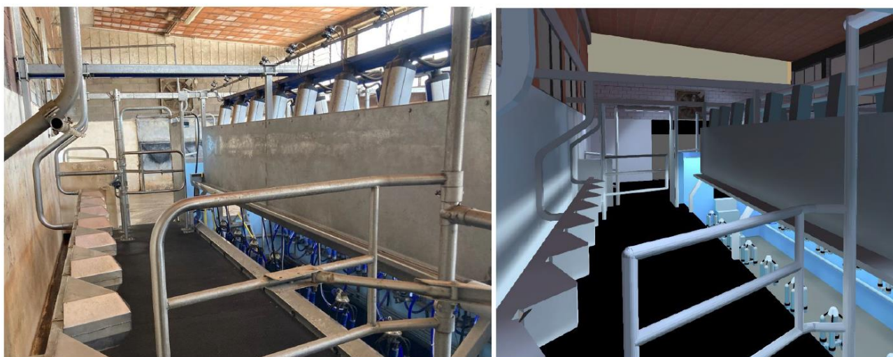
Figura 2. Le poste di mungitura reali (a sinistra) e digitalizzate con DIALux® (a destra) di una sala coinvolta nel progetto MungiLUX.
