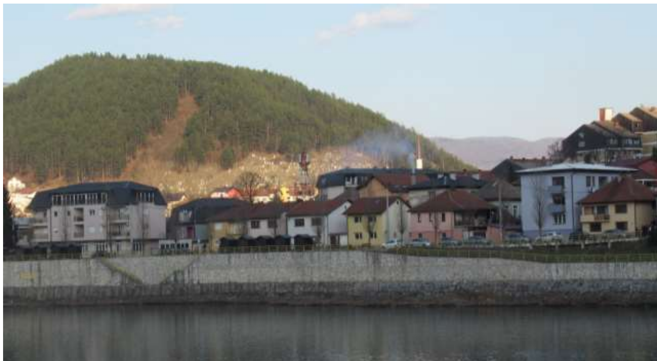
Figura 6.32: veduta del fronte fluviale della Drina dalla sponda occidentale; si scorge la punta del minareto della moschea Careva poco a destra del centro dell'inquadratura. Fotografia personale, marzo 2022.
