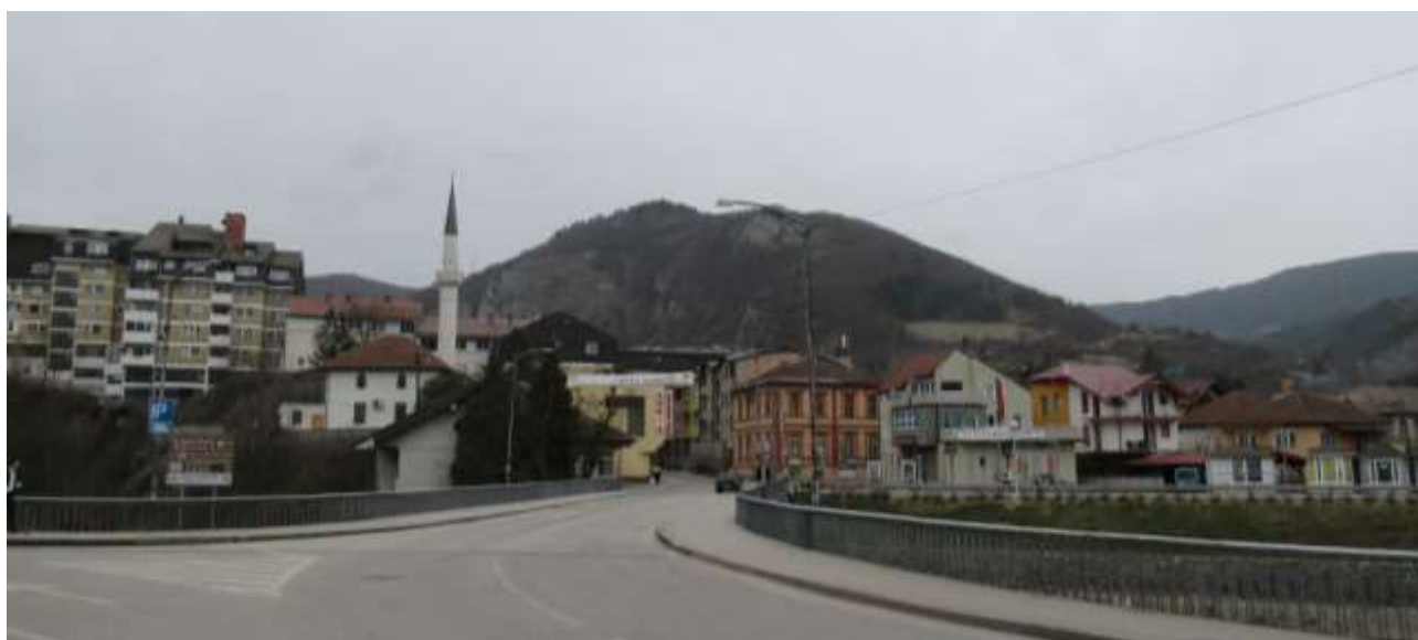
Figura 6.35: veduta del ponte sullo Rzav e dell'accesso al centro di Višegrad dalla sponda di Nova Mahala; in affaccio a sinistra si riconosce la moschea Careva di Višegrad. Fotografia personale, marzo 2022.
