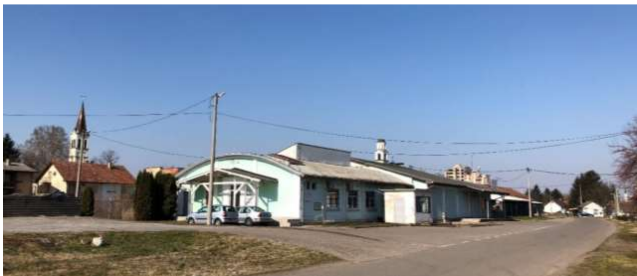
Figura 3.27: veduta dell'abitato di Brod dalla zona industriale di Rit; spiccano il campanile della chiesa cattolica (a sinistra), quello della chiesa ortodossa (al centro) e s'intravede in un'apertura tra i rami degli alberi all'estrema destra il minareto della moschea. Fotografia personale, marzo 2022.
