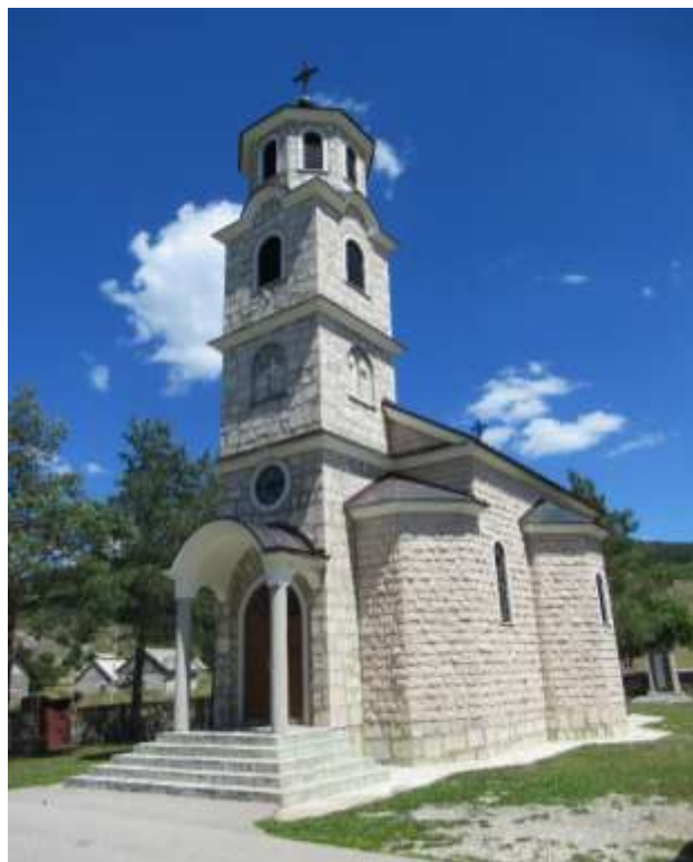
Figura 5.18: veduta esterna della chiesa parrocchiale ortodossa della Santissima Trinità di Blagaj a Novo Selo (Kupres, RS). Fotografia personale, agosto 2021.
