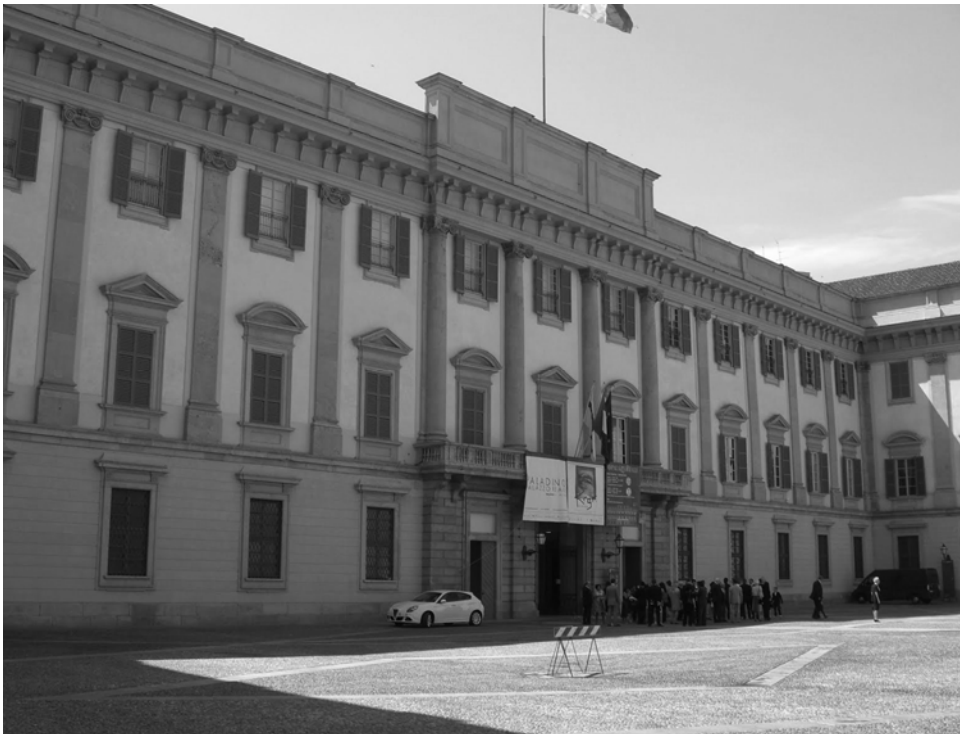
21. La facciata anteriore di Palazzo Reale. Si noti la coerenza stilistica nel confronto con quella di via Larga benché, a causa dello zoccolo già eseguito nella facciata della caserma, Tazzini sia stato costretto a erigere lesene più aggettate.
